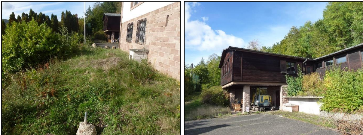
Abb. 8 u. 9: ruderalisierende Grasfläche um das Hauptgebäude der ehemaligen Jugendherberge und Sicht auf eine asphaltierten Hoffläche und Gebäude im Zentrum des Plangebietes
