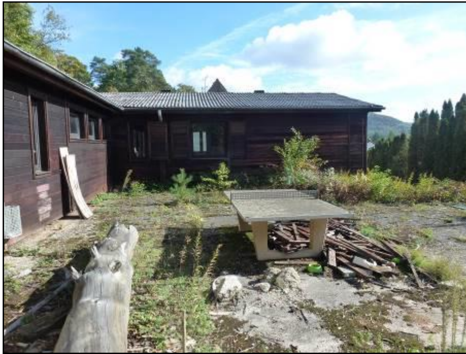
Abb. 5: Gebäudestrukturen mit ruderalisierendem Vorplatz im Nordwesten des Plangebietes
