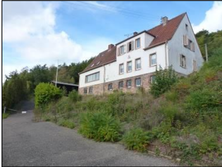
Abb. 2: Sicht auf die südlich exponierten Böschungflächen an der Tannenstraße
