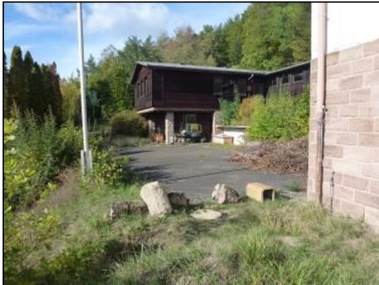
Abb. 3: Sicht auf die Gebäudestrukturen mit Hof im Zentrum des Plangebietes
