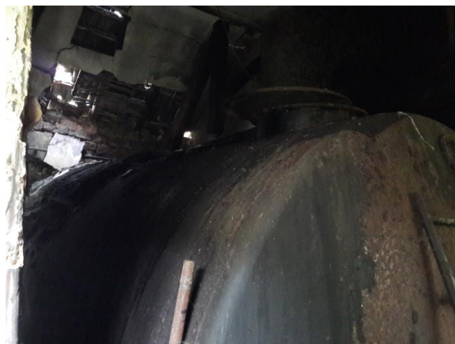
Foto 12: Schweröltank im Nebengebäude des Kesselhauses
